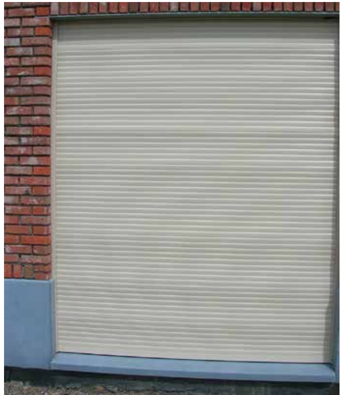
Bild 4: Welligkeit von Rollladenpanzern
